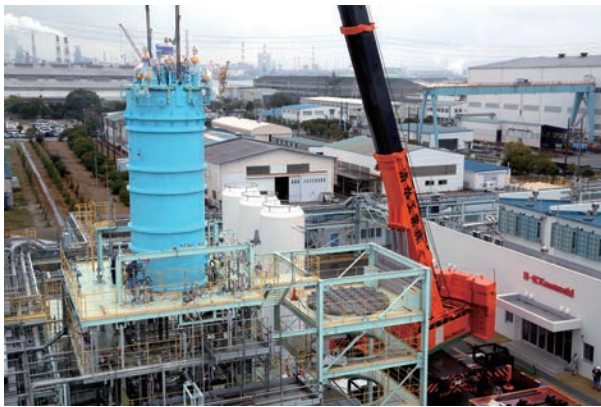
図5 新型液化機の据え付け Fig. 5 Installation of new liquefier
