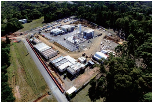
図7 ヘイスティングス港の水素液化基地 Fig. 7 Hydrogen liquefaction terminal at the Port of Hastings
