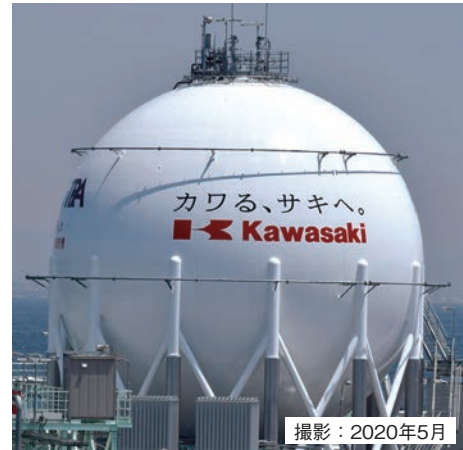
図3 液化水素タンク Fig. 3 Liquefied hydrogen storage tank
