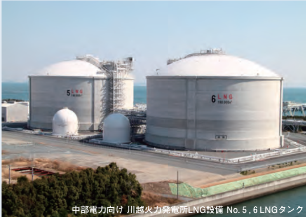
中部電力向け 川越火力発電所LNG設備 No. 5, 6 LNGタンク
