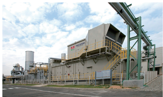
図5 明石工場エネルギーセンター Fig. 5 Akashi Works Energy Center
