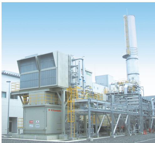
図4 PUC180Dガスタービンコージェネレーション Fig. 4 PUC180D gas turbine cogeneration system
