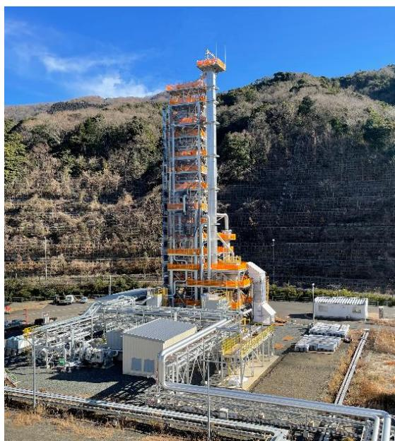
本試験設備は、国立研究開発法人新エネルギー・産業技術総合開発機構（NEDO）のカーボンリサイクル・次世代火力発電等技術開発を推進する研究開発事業として2020年に採択を受けて建設されたパイロットスケールプラントで川崎重工が設計・建設を担当、同プラントで RITE が開発・製造した固体吸収材を循環させて CO<sub>2</sub>を分離・回収します。川崎重工は、今後、本試験装置で舞鶴発電所の燃焼排ガスから CO<sub>2</sub>を分離・回収する試験を本格的に実施する予定です。
