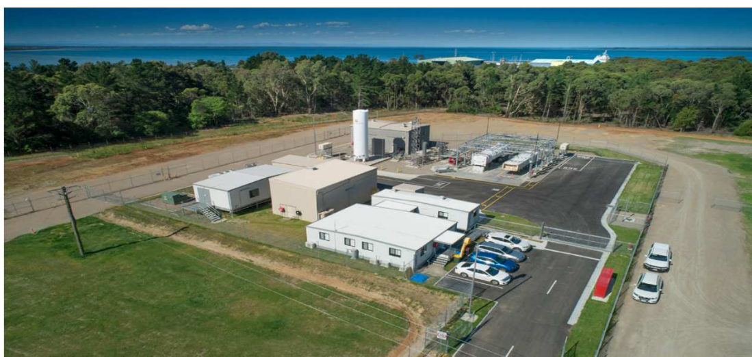
水素液化・積荷基地
