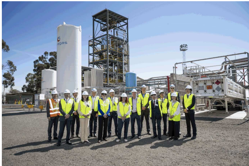
褐炭ガス化・水素精製設備公開の様子
