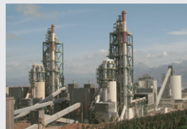
モロッコファージャ社向け 2,300トン/日セメントプラント
