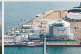
坂出LNG基地
