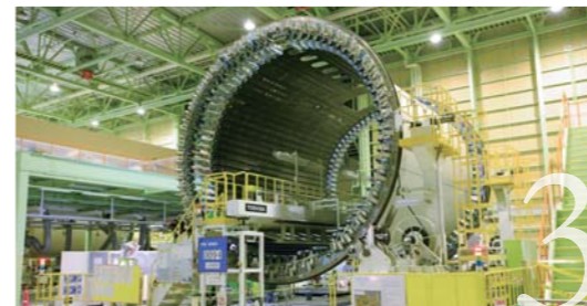
超音波による非破壊検査
