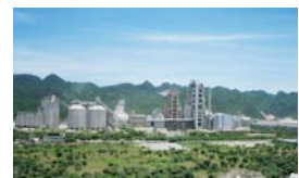
ベトナム プットソン社向け セメントプラント
