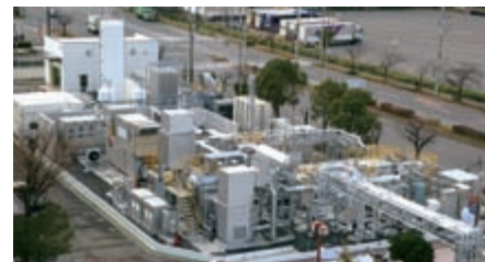
神戸ポートアイランド向け 水素焚きガスタービンコージェネレーションシステム
