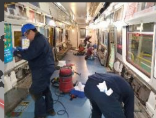
PA-5更新工事
