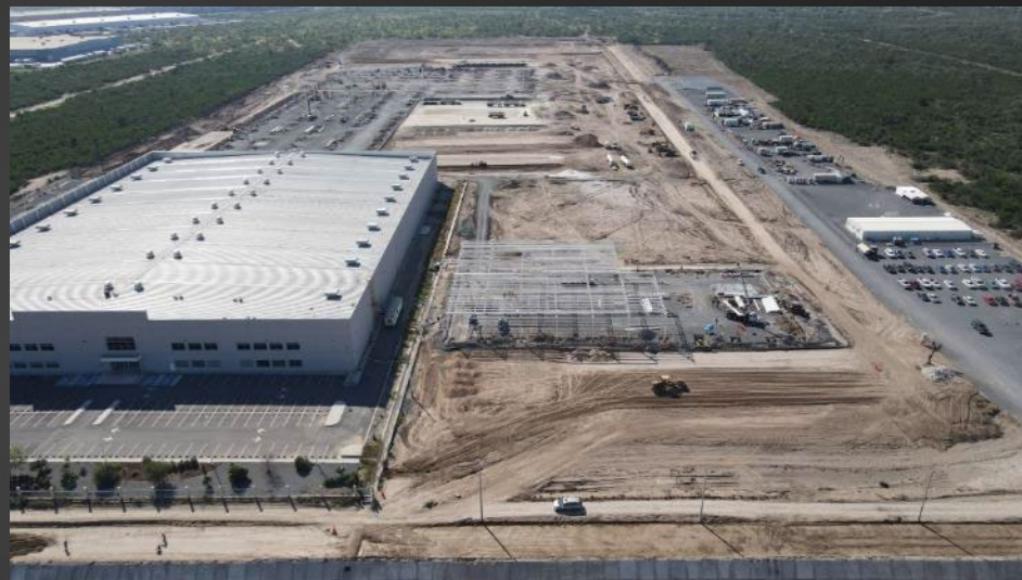
メキシコ新工場：2023年12月より稼働 (生産規模 3万台)
