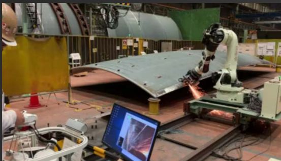
グラインダー作業 (5Gによる遠隔操作トライ開始)
