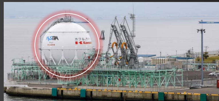
国内最大の液化水素貯蔵タンク
