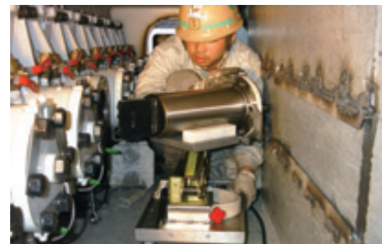
カッタービット交換作業
