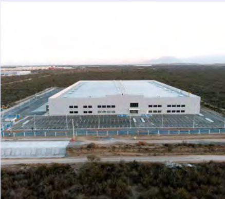
新設するメキシコ工場
