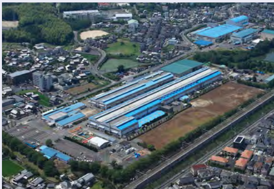
川重冷熱工業(株) 滋賀工場
