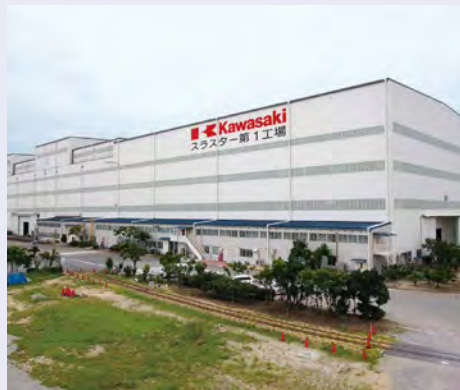
スラスター第1工場
