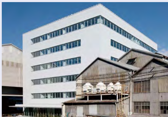
製造総合ビル
