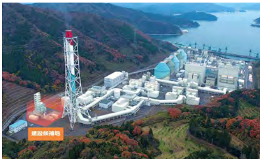
舞鶴発電所内パイロットスケール試験設備の設置イメージ (提供：関西電力株式会社)
