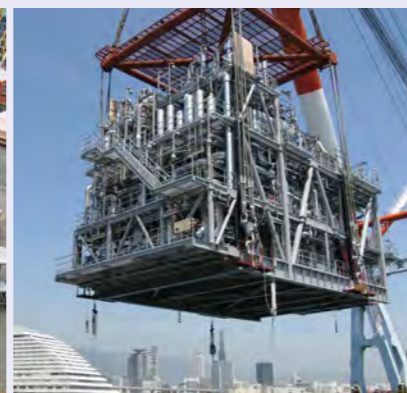
ガスコンプレッションモジュール
