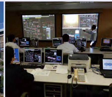
川重環境エンジニアリング株式会社のごみ焼却プラント 運転訓練シミュレータ
