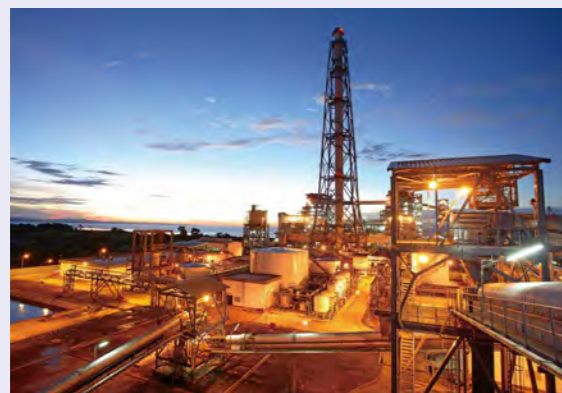
フィリピンSPI石炭焚き事業用火力発電所
