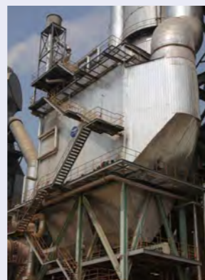
安徽海螺水泥股份有限公司(海螺セメント)に納入した排熱発電設備
