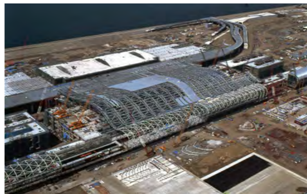
施工中の関西国際空港旅客ターミナルビル——南側工区屋根鉄骨を担当
