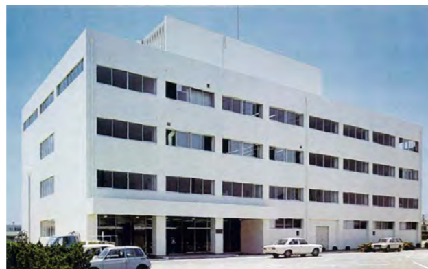
明石工場内に建設された技術研究所——1971年に竣工
