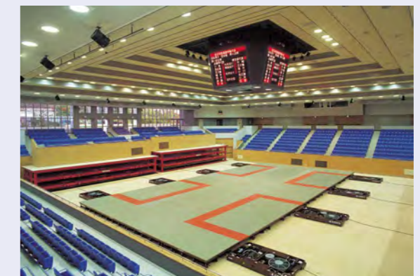
兵庫県立武道館(ウインク武道館)の床転換装置
