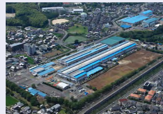
川重冷熱工業(株)滋賀工場
