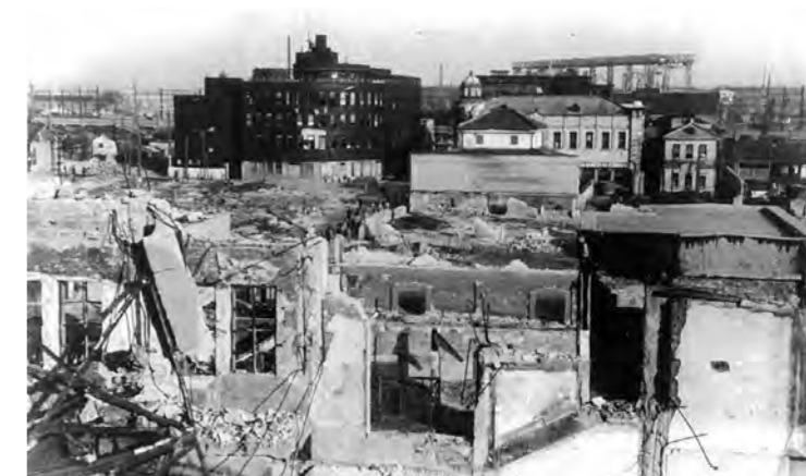
空襲による神戸の被害——右遠方にガントリークレーンが見える
