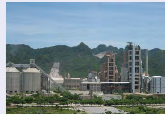
プトソンセメント社向けセメント製造一貫プラント
