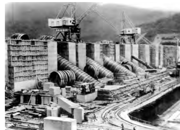
施工中の松花江発電所(満州国)水圧鉄管据付工事——1944年に製作
