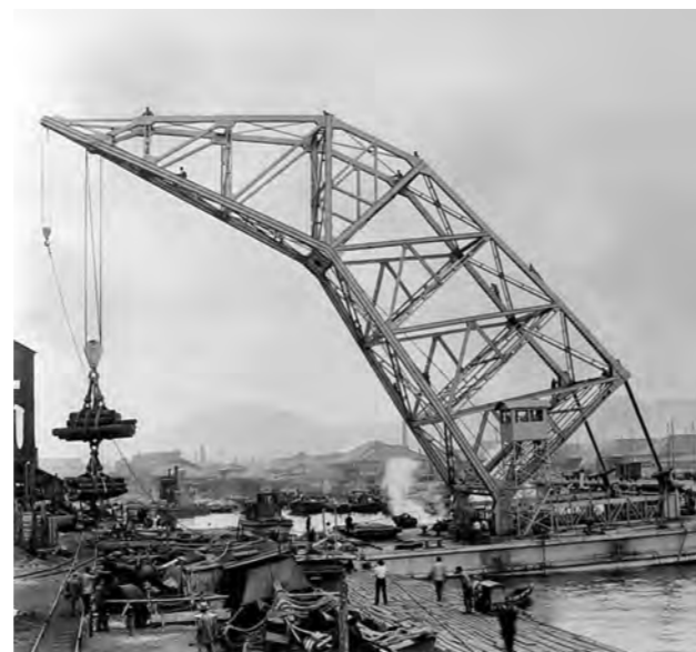
150トン起重機船——右奥は鉄道栈橋(1908年)
