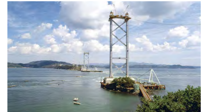
架設工事中の大鳴門橋主塔——竣工は1981年
