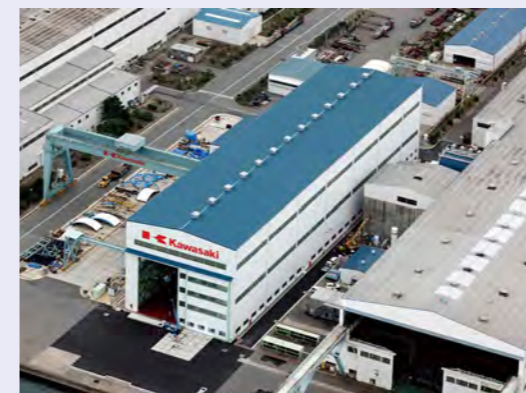
播磨工場の大型ボイラ製品組立用工場
