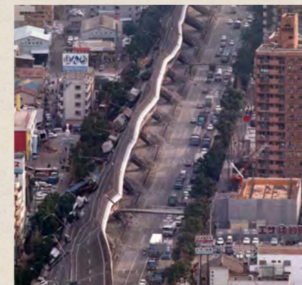
阪神・淡路大震災で倒れた高速道路
