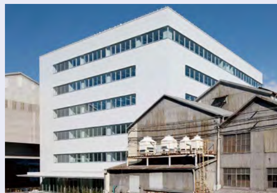
製造総合ビル
