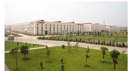
安徽海螺川崎節能設備製造有限公司(CKM)工場棟
