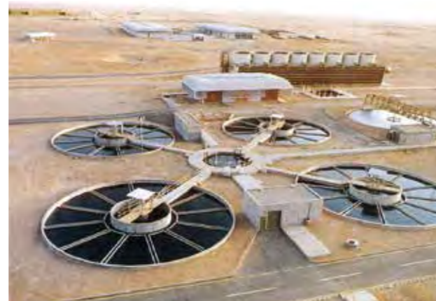
ワシヤ(サウジアラビア) 上水処理プラント—1982年に完成
