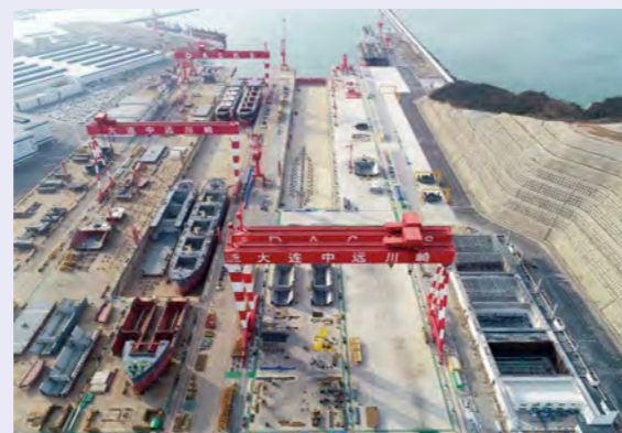
DACKS第2ドック
