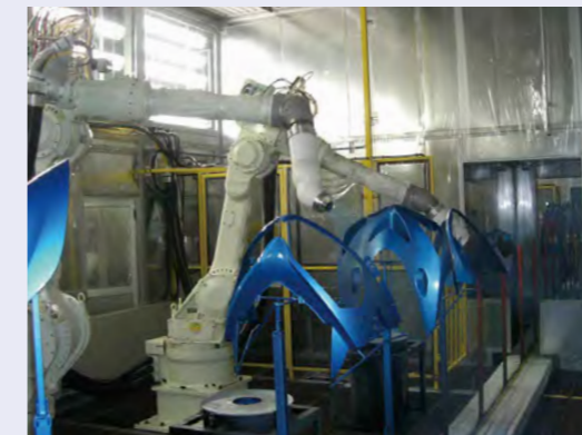
新樹脂塗装工場のロボットによる塗装現場
