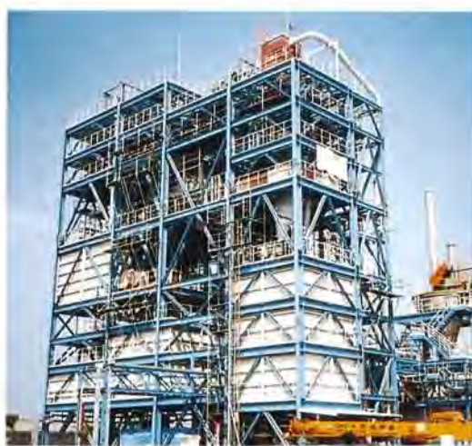
加圧CPCパイロット試験装置
