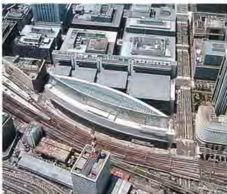
東京国際フォーラム〈ガラス棟〉——1995年
