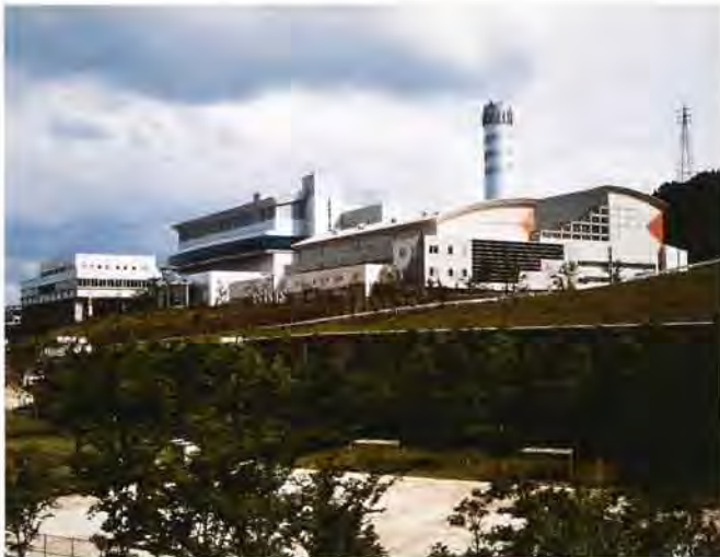
粗大ごみ処理設備
