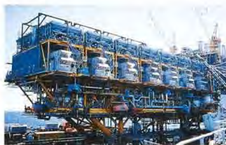
ONGC/SHG向けモジュール （海上プラットフォーム据付）——1994年
