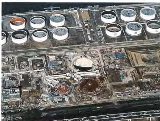
東京ガス・扇島工場(環境保全・安全を実現したわが国初の全埋設式LNGタンク)
