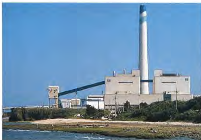
事業用石炭焚ボイラ
