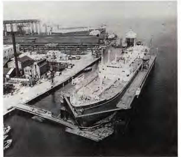
第3浮きドック
