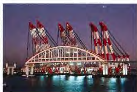
六甲アイランド橋3隻吊り大ブロック架設
