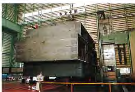
明石海峡大橋主塔端面切削状況
