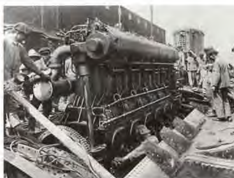
ラ式1号ディーゼル機関の積込(潜水艦「伊21」)——1926年
