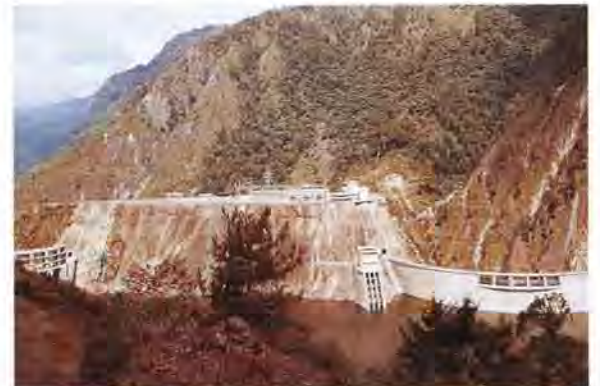
台湾電力・達見ダム止水・制水設備——1969年
