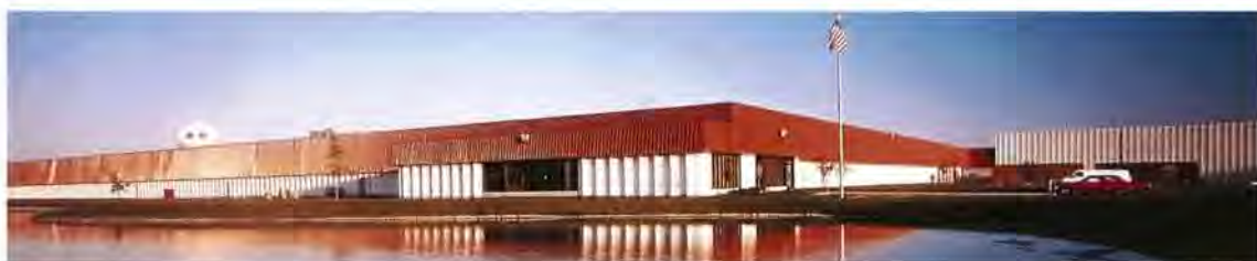
KMCのリンカーン工場
