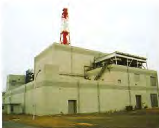
高温工学試験研究炉（HTTR）施設
