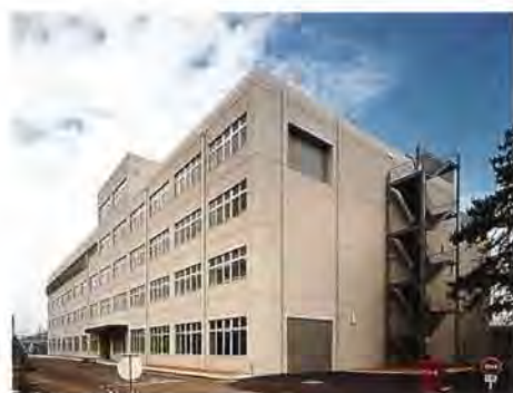
電子関係作業のメッカ「機能試験センター」
