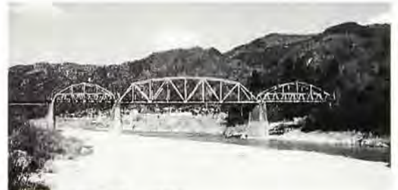
関西本線・木津川鉄橋——1887年
