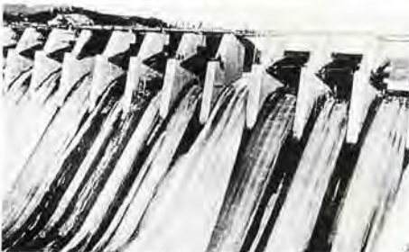
大同電力・大井発電所ダムゲート——1925年
