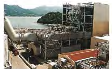
関西電力・宮津発電所向け排煙脱硝装置
