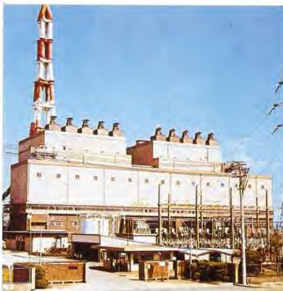
ベンソンボイラ（九州電力・新小倉発電所2号機）
