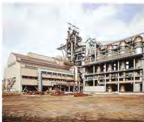
川崎製鉄・千葉製鉄所第6高炉——1977年
