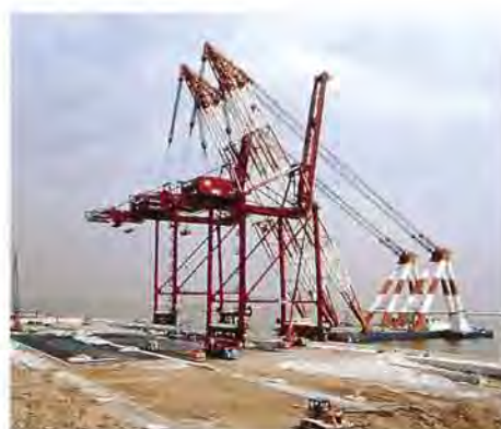
神戸港・六甲アイランドコンテナクレーン——1995年
