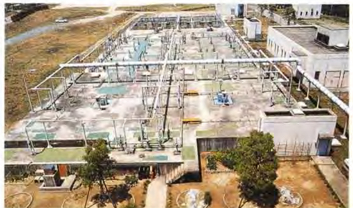
福岡県宝満浄化センター(下水処理場)
