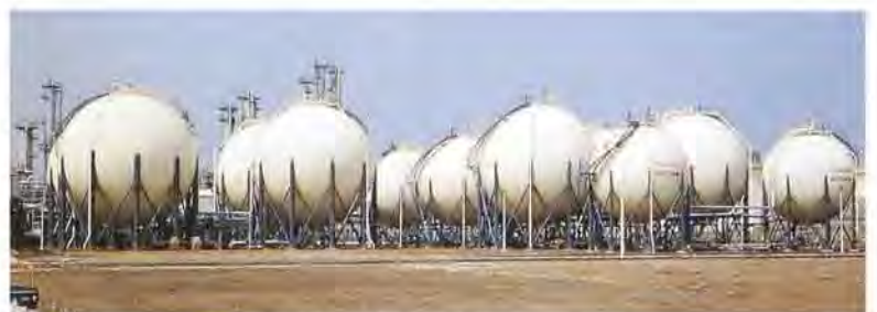
丸善石油化学・千葉南工場エチレン球形タンク（HT60鋼）
