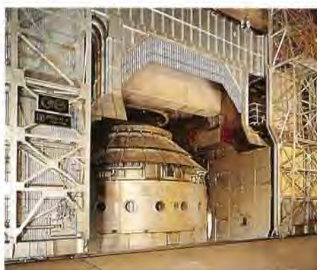
川崎製鉄・千葉製鉄所向け転炉プラント——1993年
