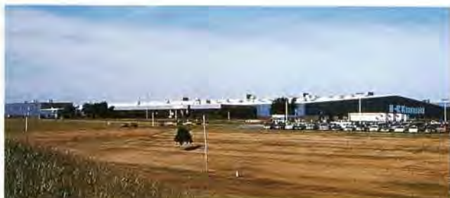
KMMメアリービル工場
