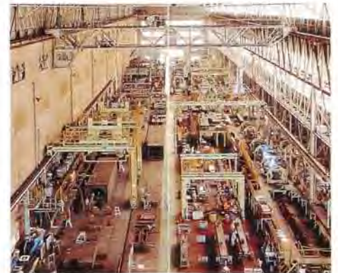
ビル鉄骨一個流し生産ライン
