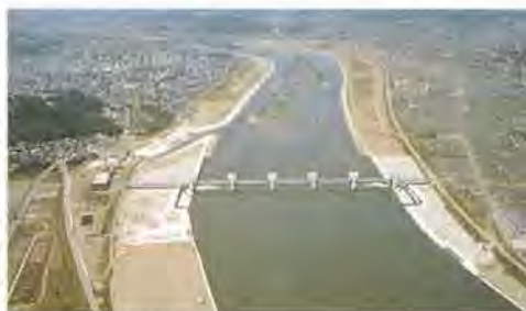
建設省・加古川大堰
