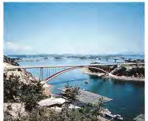
日本道路公団・天草パールライン松島橋——1966年
