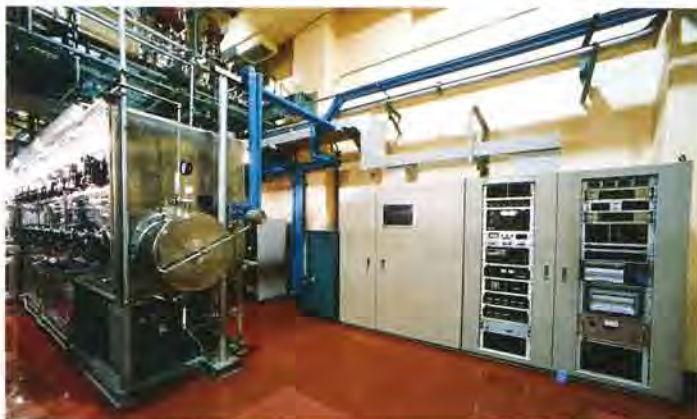
日本原子力研究所向けトリチウムプロセス試験施設
