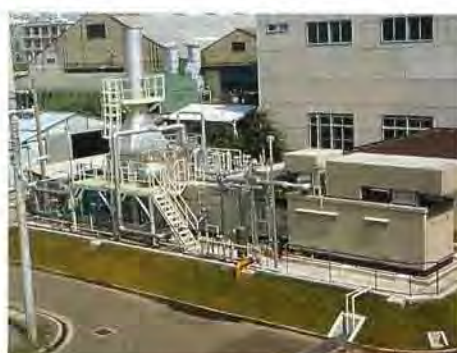
チェンサイクル・ガスタービン・コージェネレーションシステム—1988年
