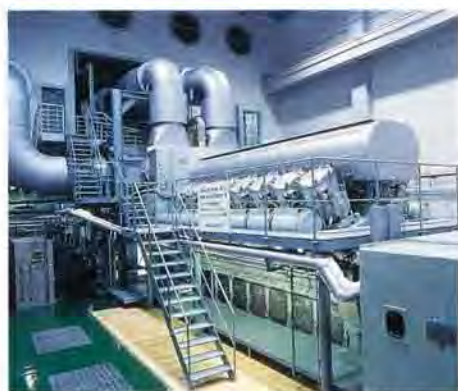
川崎-MAN B&W 16V52/55B型ディーゼル機関（沖縄電力石垣第2発電所用10MW）——1989年
