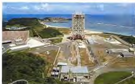
H-Iロケット発射設備
