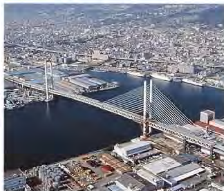
阪神高速道路公園・東神戸大橋——1993年
