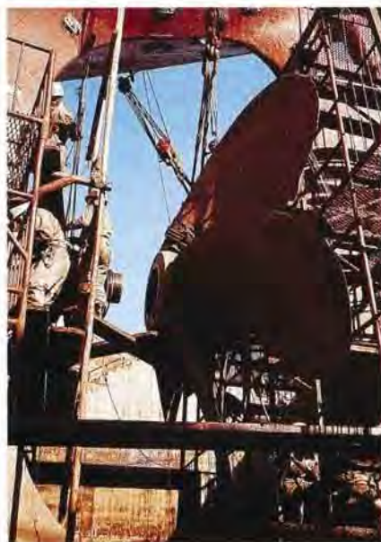
修繕工事（軸系工事）
