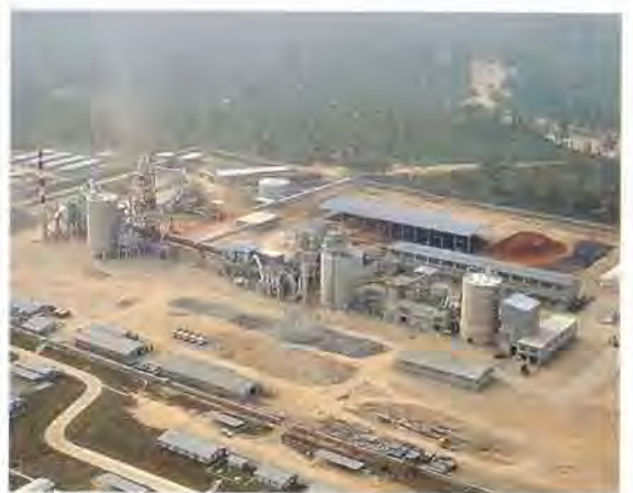
ネパール向けセメントプラント——1993年
