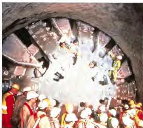
英仏海峡海底鉄道トンネル向け8.78m TBM——1988年
