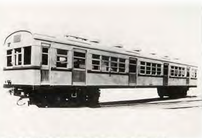
モハ63形電車(航空機用ジュラルミン合金を使用)——運輸省に1946年納入
