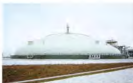
東京ガス・袖ヶ浦工場LNG地下式貯槽——1989年
