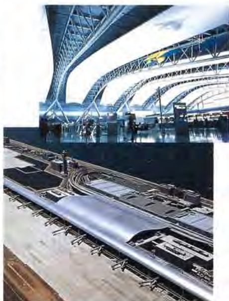
関西国際空港旅客ターミナルビル鉄骨——1993年
