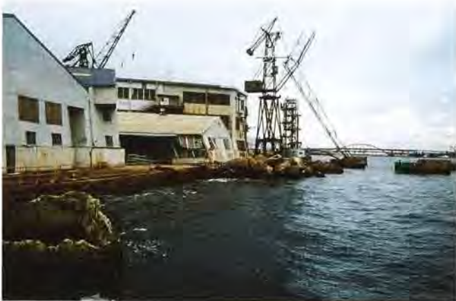
神戸工場の被災状況
