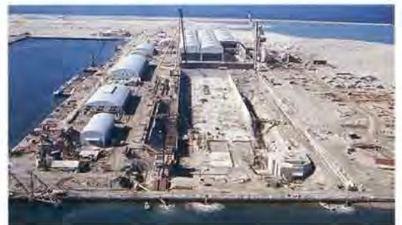
坂出工場の建設風景
