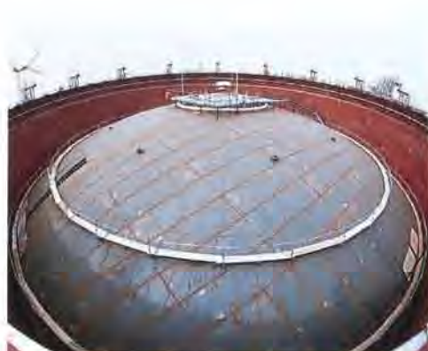
LNGタンク屋根エアレイジング工法
