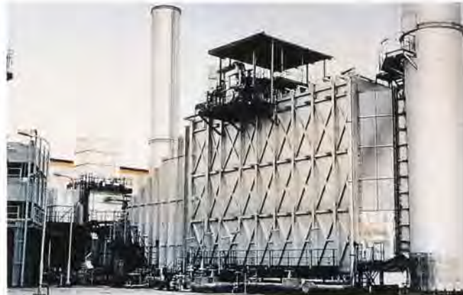
ガスタービン用廃熱ボイラ（HRSG）
