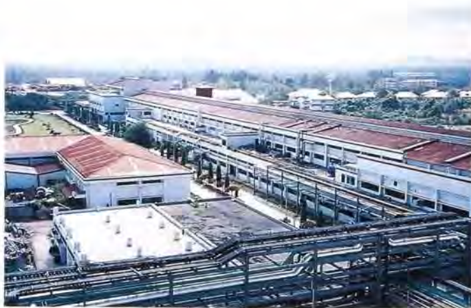
タイ向けアクリル繊維プラント工場——1990年
