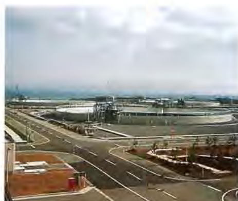
秋田石油備蓄・地下式原油タンク——1992年
