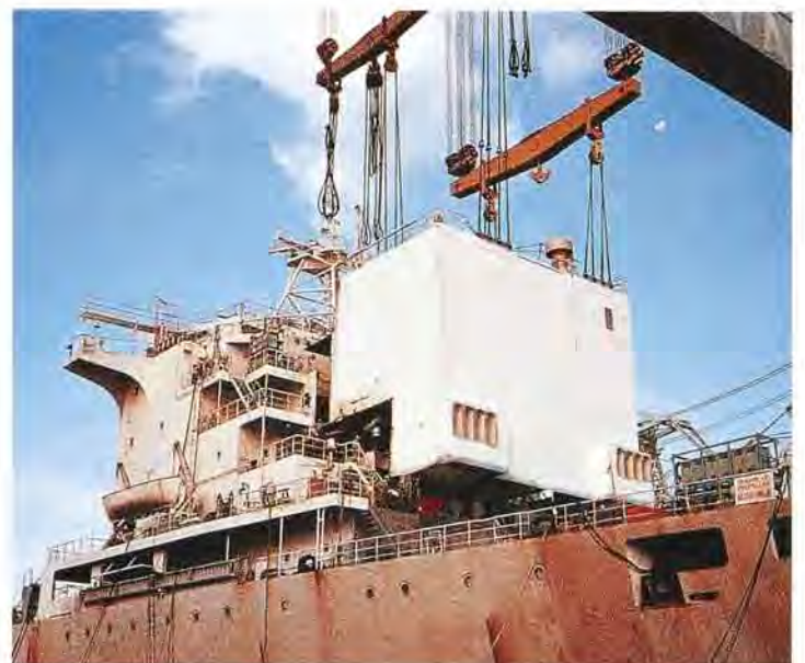
主機換装工事
