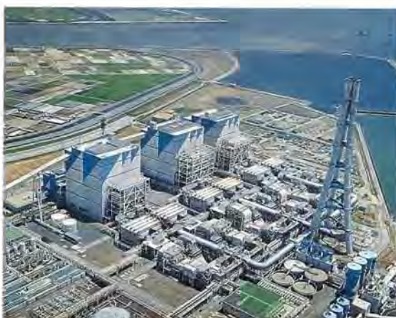
中部電力・碧南火力発電所向け排煙脱硫装置——1992年
