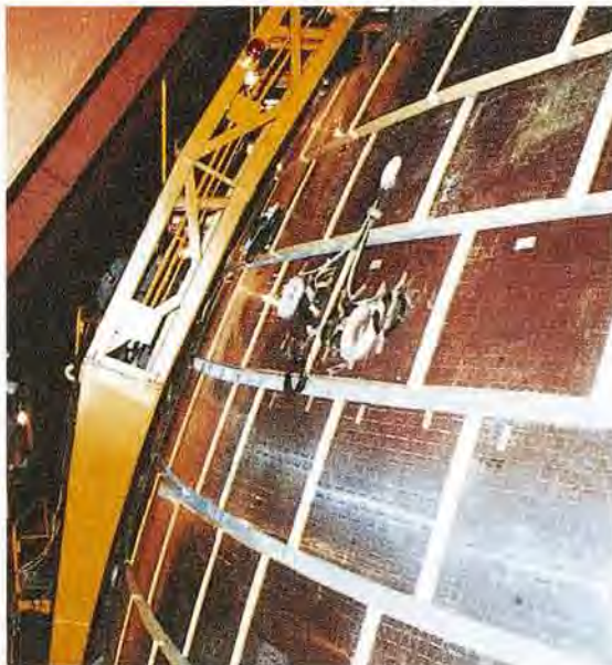
LNGタンク防熱
