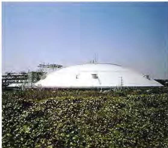
東京ガス・根岸工場LNG地下式貯槽——1982年
