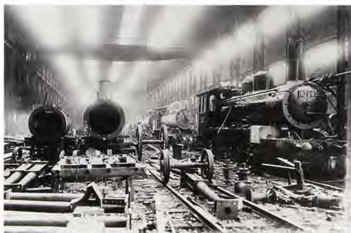
鉄道院向け6700形蒸気機関車を製造中の兵庫分工場(1910年頃)
