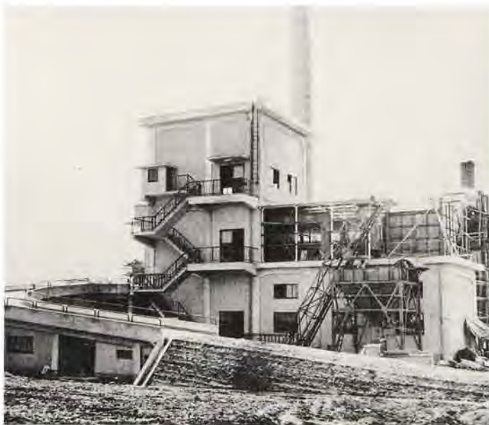
愛知県一宮市向け都市ごみ焼却プラント(処理量120トン/日、自動車造製) —1964年
