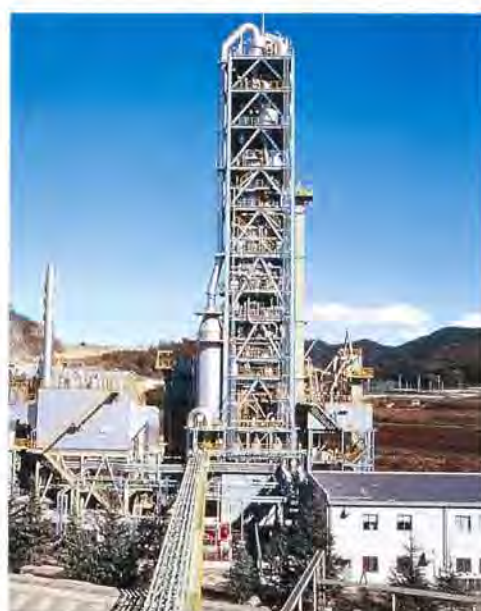
流動床セメント焼成装置
