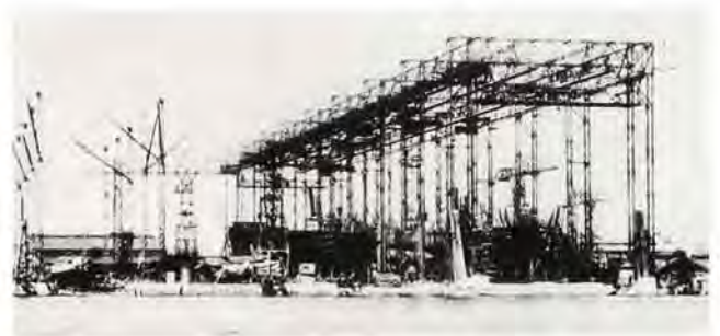
ガントリークレーン
