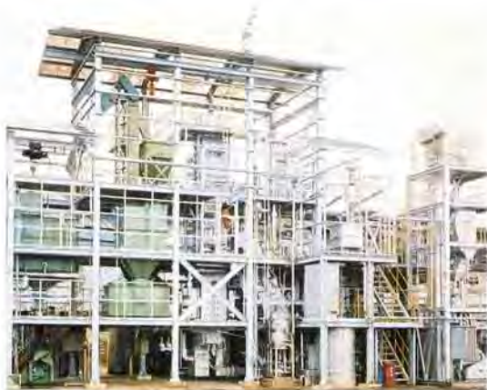
流動床ボイラテストプラント
