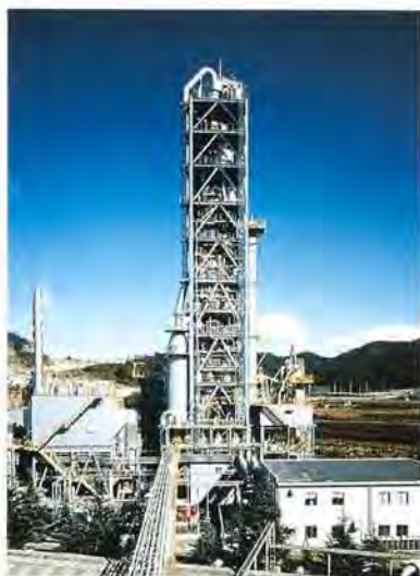
流動床セメント焼成スケールアッププラント——1996年
