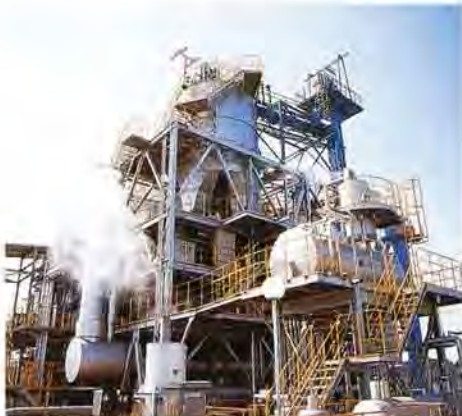
鳴戸塩業・徳島工場向け石炭焚流動層ボイラ
