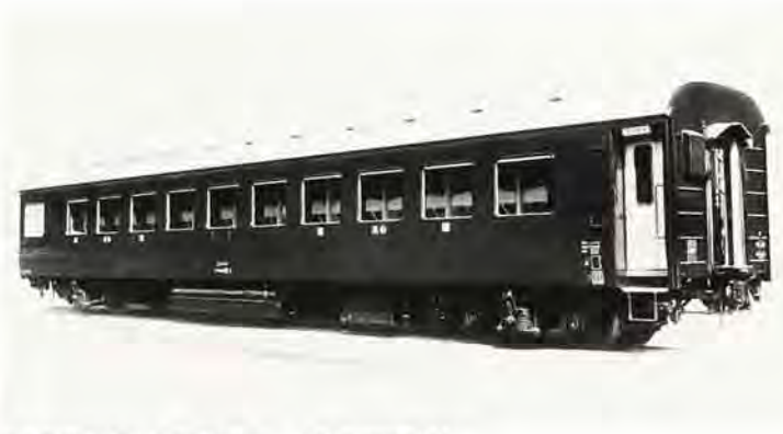
ナハネ10形軽量鋼製三等寝台車——国鉄に1956年納入
