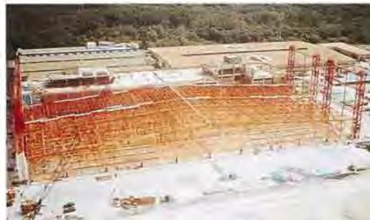
リフトアップ工法／大屋根（鋼重2,200t）のリフトアップ
