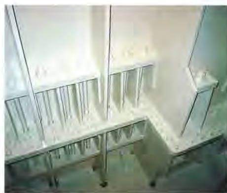
来島大橋主塔引張ボルト継手
