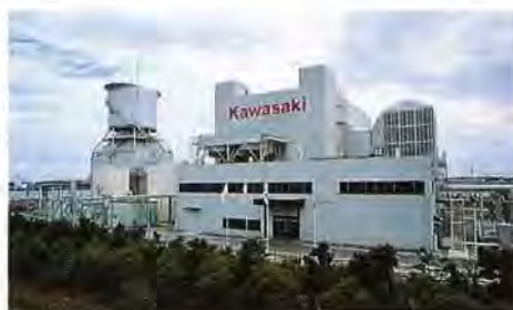
川重ガスタービン研究所——1992年
