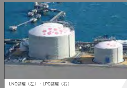
LNG儲罐 (左)、LPG儲罐 (右)
